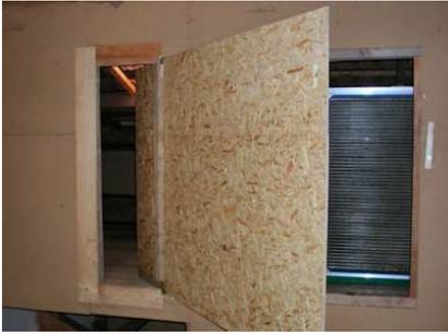
Bild 22: Umluftklappe
