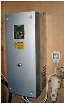
Bild 10: links Frequenzumformer
